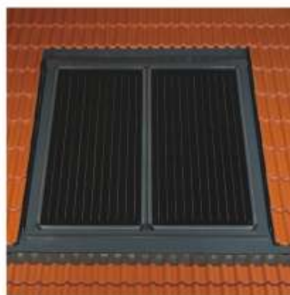
Fig. 2-23: Vedere finală montare în acoperis
