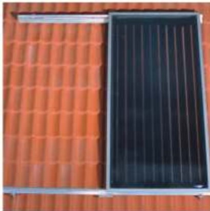
Fig. 2-8: Primul colector montat pe un câmp dublu
