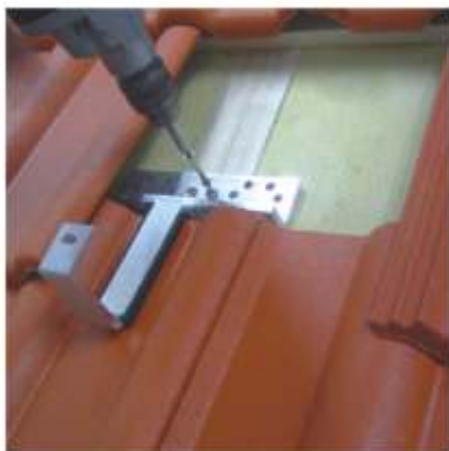
Fig. 2-5: Montarea etrierilor pe capriori
