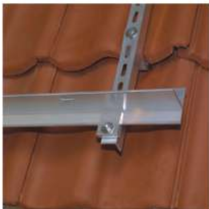
Fig. 2-6: Profil transversal si longitudinal montat pe etrier.
