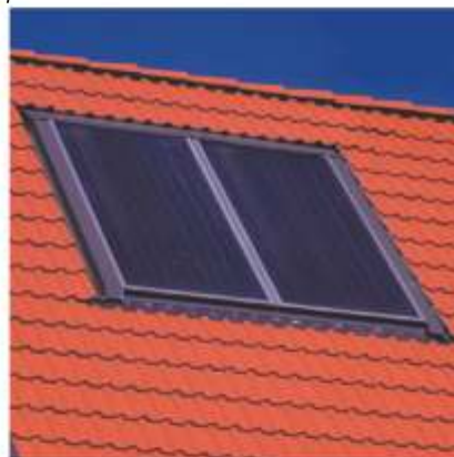
Fig. 2-10: Vedere asupra unui sistem finit montat în acoperis
