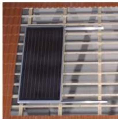
Fig. 2-9: Exemplu de montare în acoperis pe o constructie
